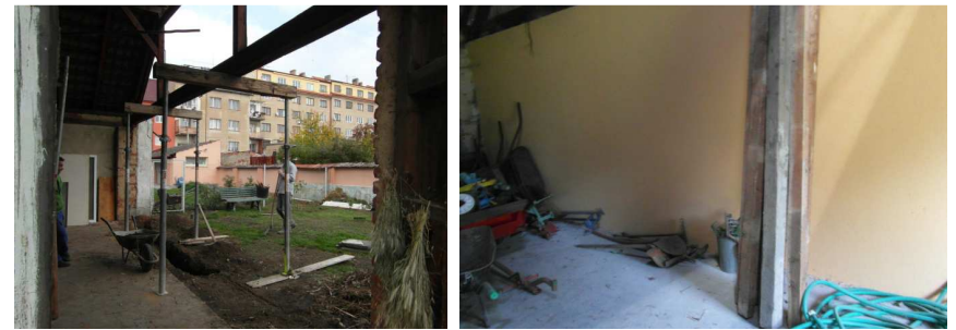
Bouda na nářadí si žádala zásah, a to nejen materiální a fyzický, ale hlavně administrativní. Obojí si vzal za své pan ředitel Mgr. Pavel Koc. Díky němu se opravila západní stěna a střecha, sám vyklidil vnitřní prostory a kromě zlepšení stavu budovy „vytunil“ i vztahy se sousedy☺.
